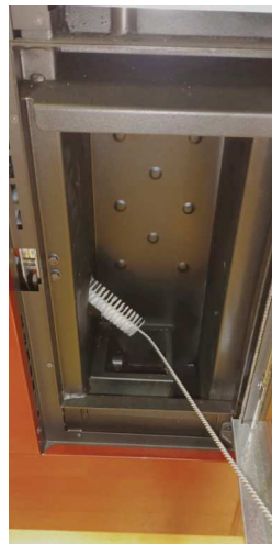
Fig. 45 - Limpieza con escobilla
