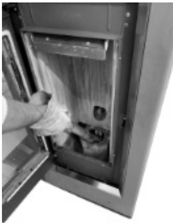
Fig. 35 - Limpieza alojamiento brasero
