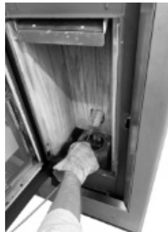
Fig. 36 - Limpieza con escobilla
