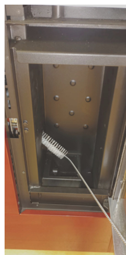
Fig. 35 - Limpieza con escobilla
