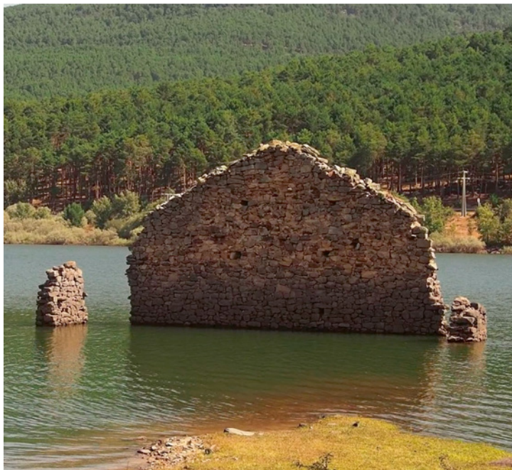
Viejos edificios sobresalen del embalse de La Cuerda del Pozo ↓
