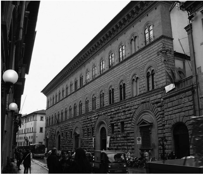
Palacio Medici en vía Cavour, Florencia.
