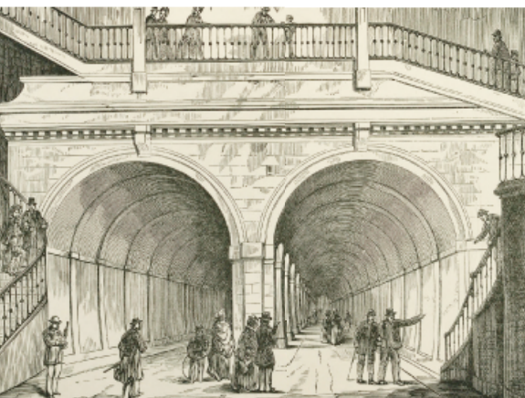
Túnel bajo el Támesis.
