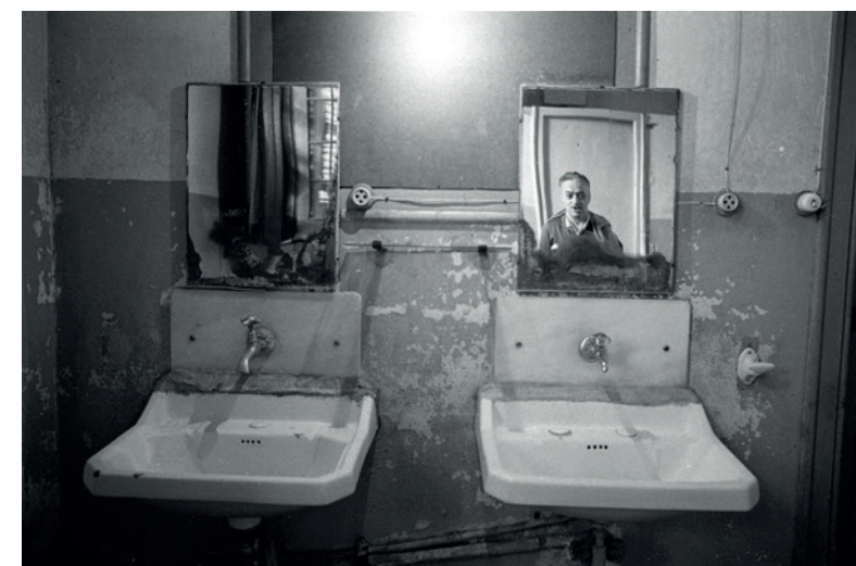
Estado de las instalaciones en el psiquiátrico.
