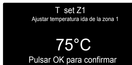
Modificar la temperatura agua caliente calefacción
